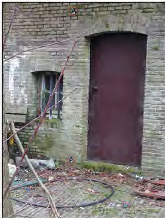
Figuur 4: Voorbeeldfoto positie prisma's (rood omcirkeld)
